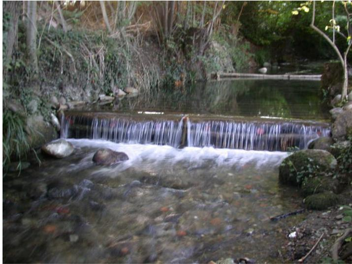
Vue vers l'amont, avec le seuil creux créant une grande zone de cache donnant sur la fosse de dissipation d'énergie creusée par la chute.
