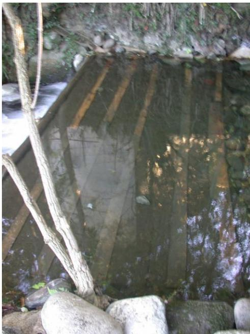
Le platelage est visé sur le cadre, une couche de géotextile coco 740 g le recouvre, le coco est maintenu sur le platelage par des traverses servant également de couvre joint du platelage.
