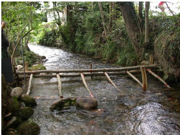
Le cadre est monté sur place sur place en contrôlant régulièrement que la hauteur ne soit pas supérieure à 35 cm
